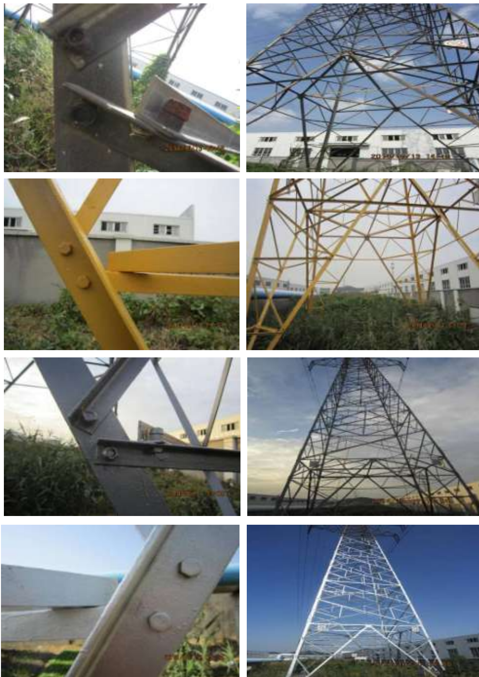
北鄞 2321 线 3#输电铁塔示范工程现场
