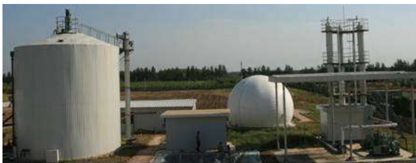
图 1：青岛平度市建成的秸秆发酵、沼气净化、车用生物天然气中试项目
