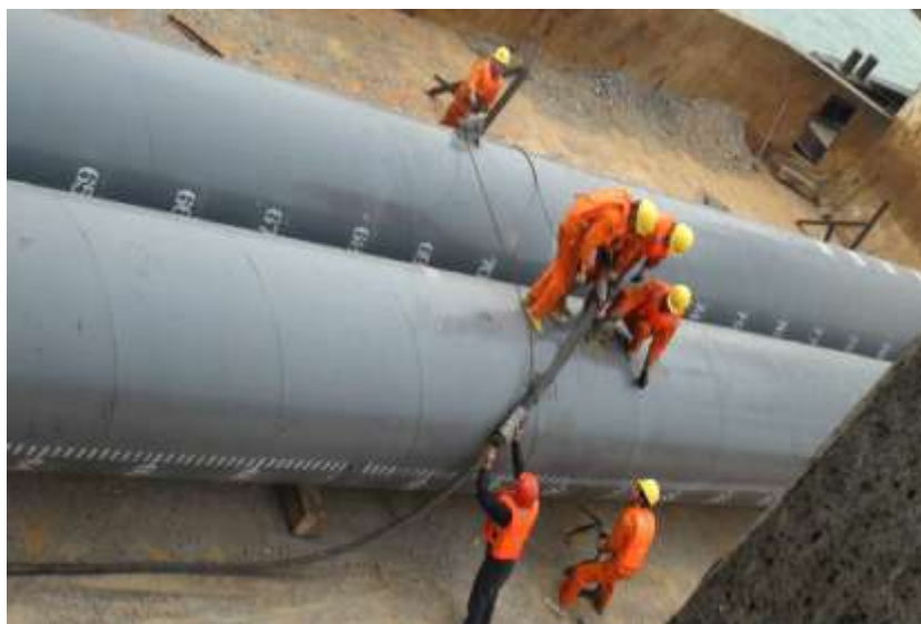
港珠澳大桥钢管桩 SEBF 外壁防腐
