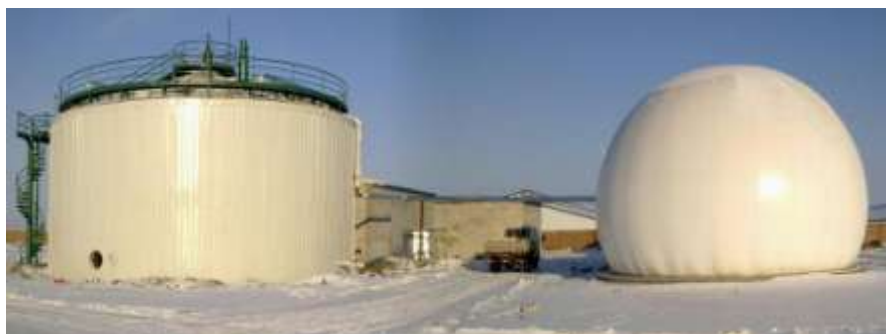
图 2：吉林白城建成的秸秆生物天然气产业化示范工程
