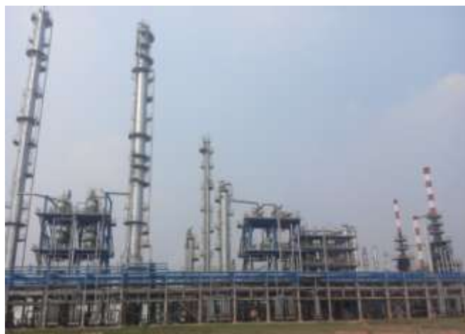
6 万吨/年低碳烃与轻芳烷基化生产高辛烷值汽油调和组分工业装置
