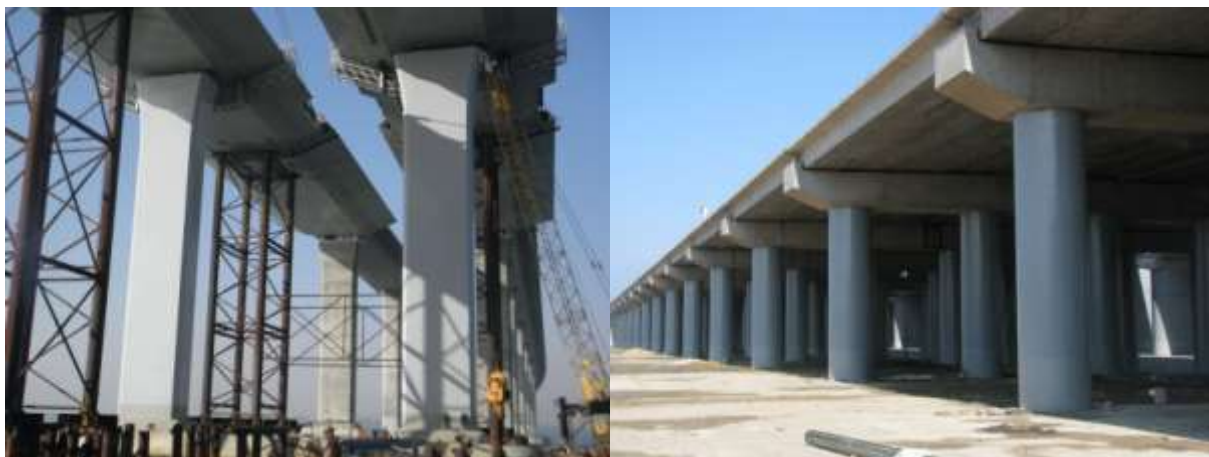
青岛海湾大桥混凝土涂装工程 潍坊白浪河防潮闸混凝土涂装工程
